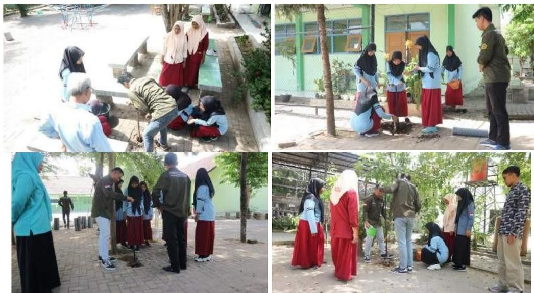
**Gambar 5.3.** Pelaksanaan pembuatan Lubang Biopori menggunakan bor tanah manual
