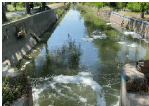
Gambar 2. Saluran Drainase Di Hulu Saluran
