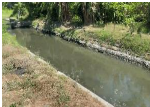
Gambar 3. Saluran Drainase Sekunder
