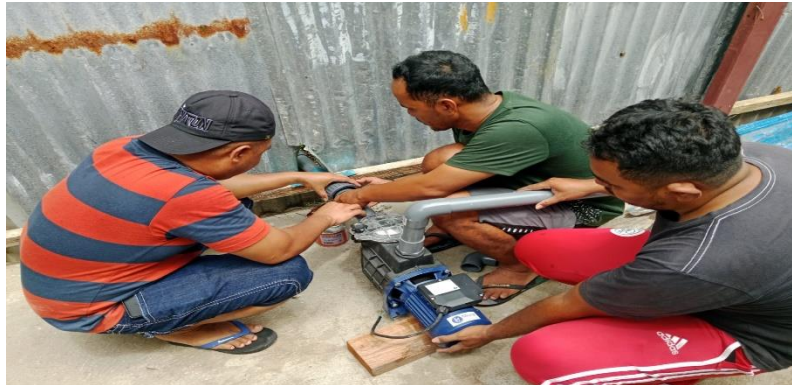
Gambar 3. Pengerjaan Pipa dan Pemasangan Pompa Air Laut
