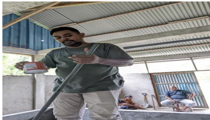
Gambar 5. Pemasangan Pipa Untuk Instalasi Aerasi Pada Bak-Bak Hachery
